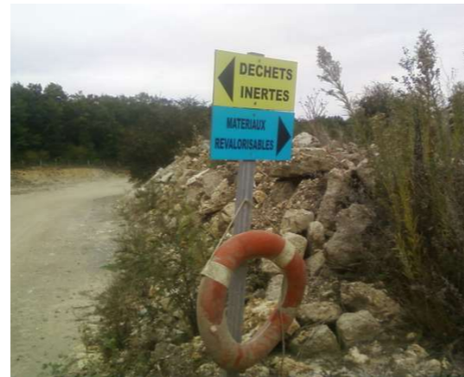
Signalisation pour éviter le mélange des matériaux lors du déchargement
